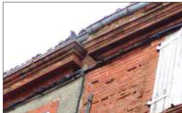
corniches de terre cuite moulurée
