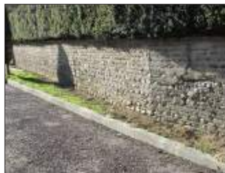
mur de clôture en assises galets
