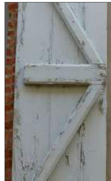
contrevents à écharpes chanfreinées - détail
