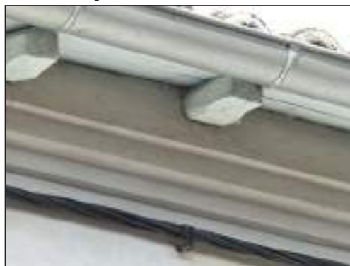
avant-toit sur corniche moulurée
