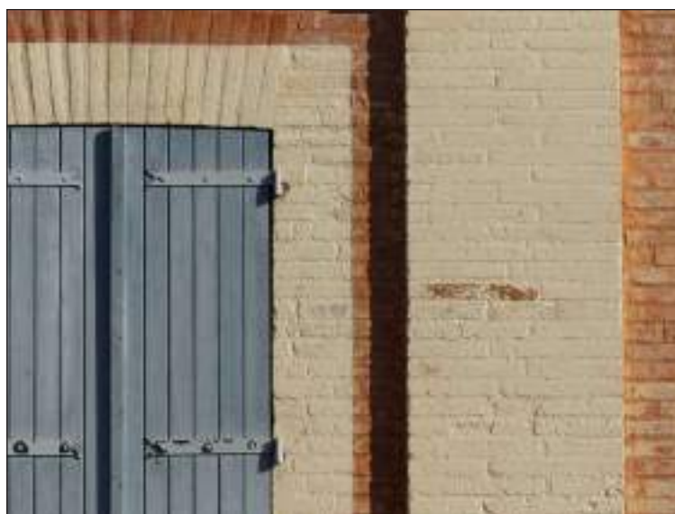
parement de briques cuites rehaussé par badigeon
