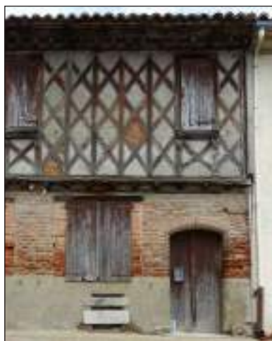
Façade en pan de bois d'intérêt majeur
