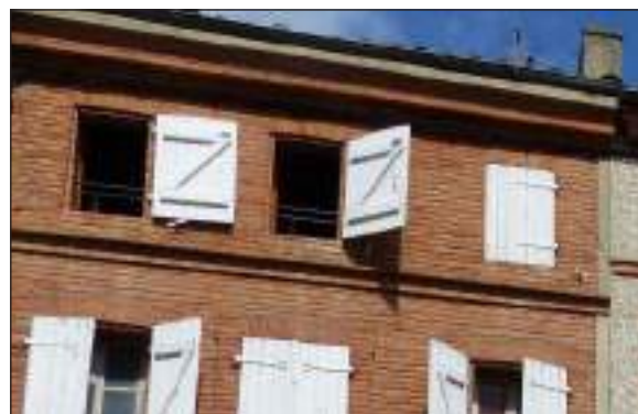
baies d'attique néoclassiques
