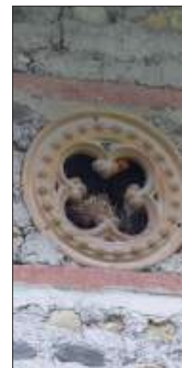
aération de comble néogothique
