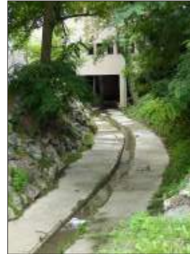
rue de l'Éperon
