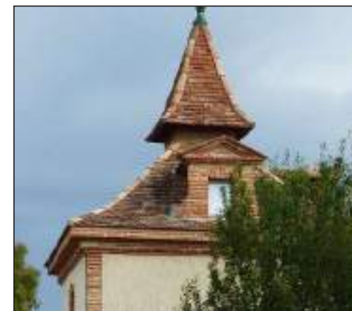
toiture en pavillon avec lanternon et épi de faîtage
