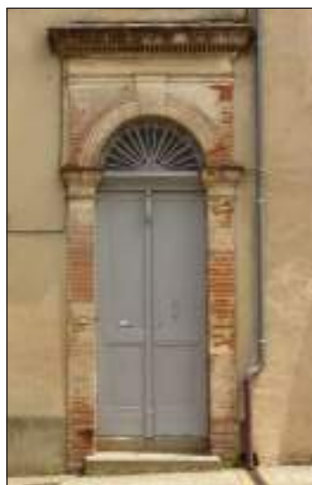
porte à vantaux moulurés et imposte rayonnante
