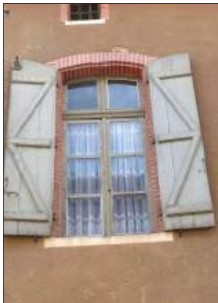
châssis à traverse dormante - contrevents à écharpes
