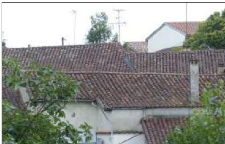
couvertures de tuiles canal
