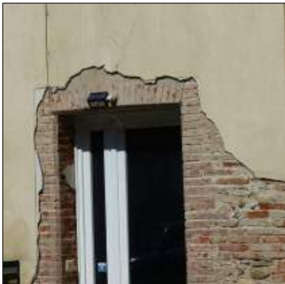
porte chanfreinée et appareil de briques
