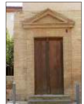
porte à entablement et fronton 19 e siècle. 14, rue Bastide
