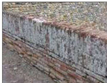
chaperon de briques sur chant (ouvrages d'art)
