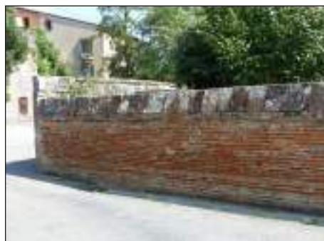
mur de clôture en briques pleines apparentes
