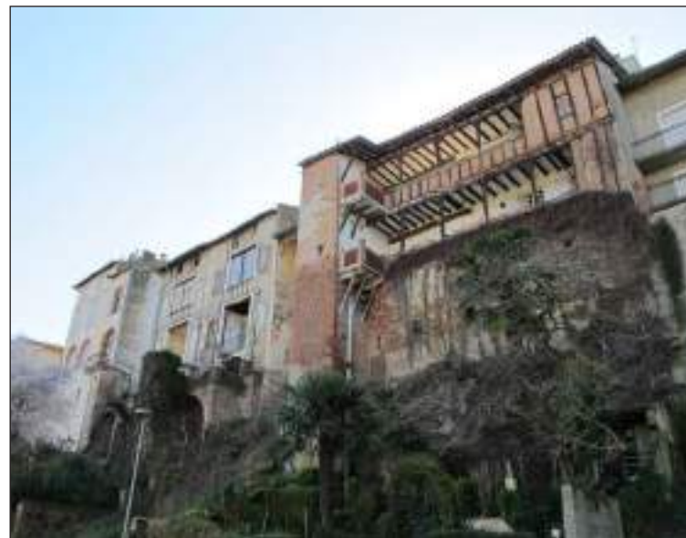
Verdun, le front urbain et ses encorbellements
