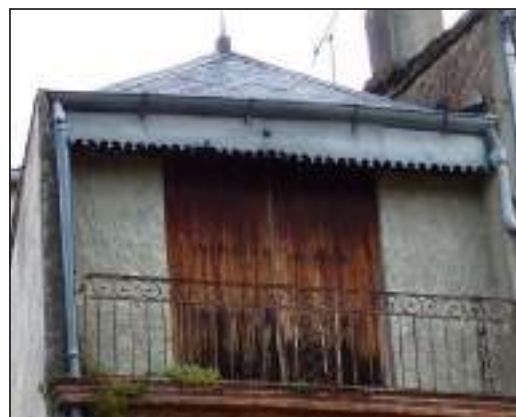
couvertures d'ardoises et lambrequin de tôle découpée
