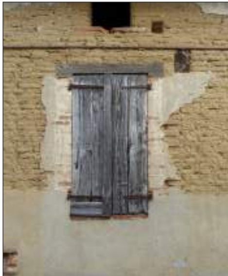
vestiges d'enduit sur parement de briques crues
