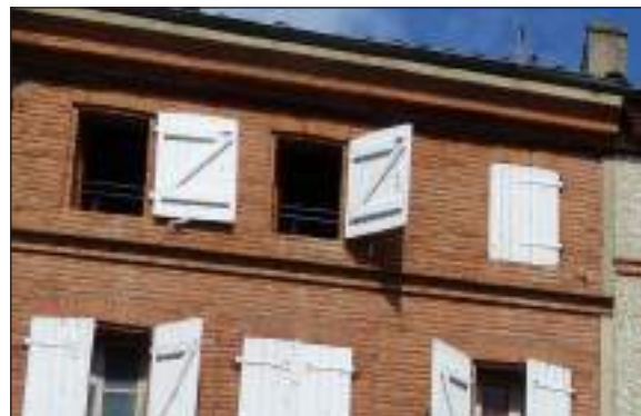
baies d'attique néoclassiques
