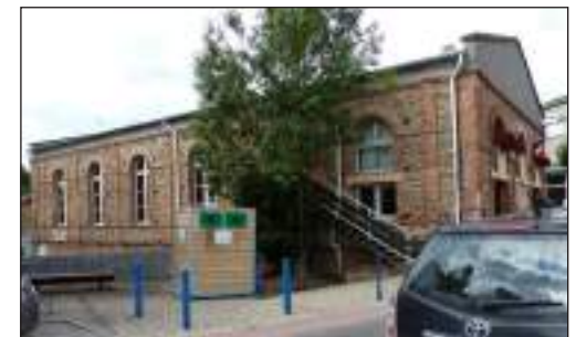
salle des fêtes - parements de galets et de briques
