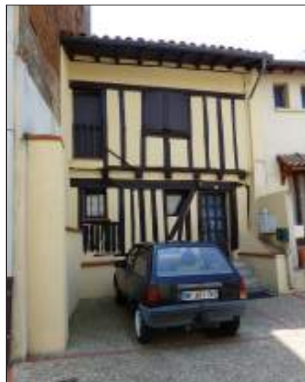
Façade en pans de bois 17e siècle, banalisée par l'apport d'un crépi inadapté et le traitement trop sombre des bois
