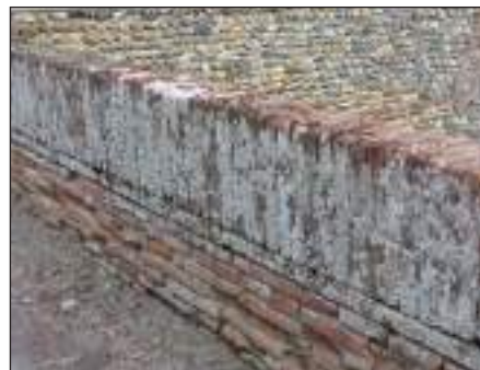
chaperon de briques sur chant (ouvrages d'art)
