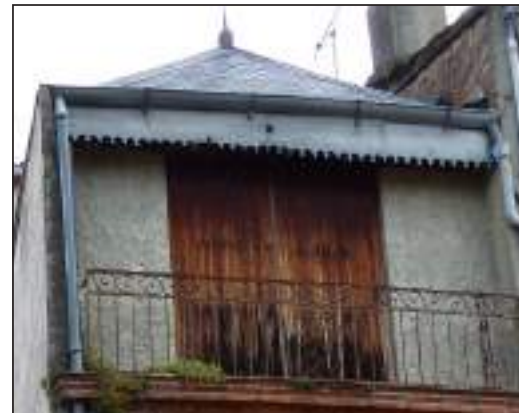
couvertures d'ardoises et lambrequin de tôle découpée
