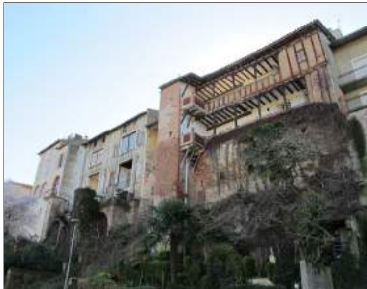
Verdun, le front urbain et ses encorbellements
