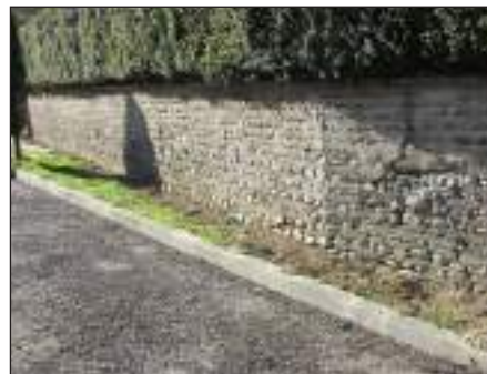
mur de clôture en assises galets
