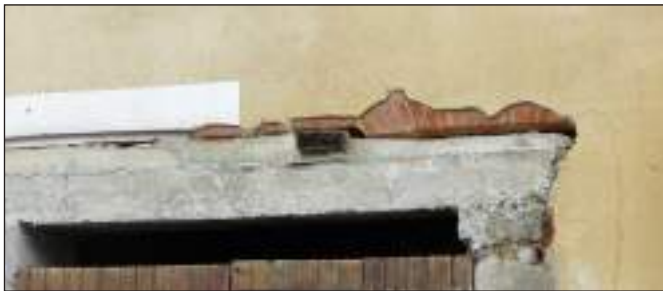
linteau clavé et chanfreiné remplacé dans un premier temps par une baie à chambranle simulé puis par un linteau de béton
