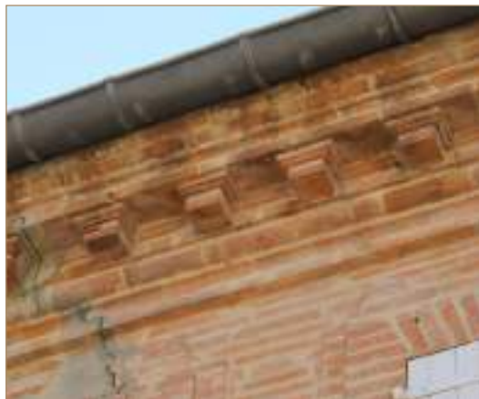
corniches à modillons
