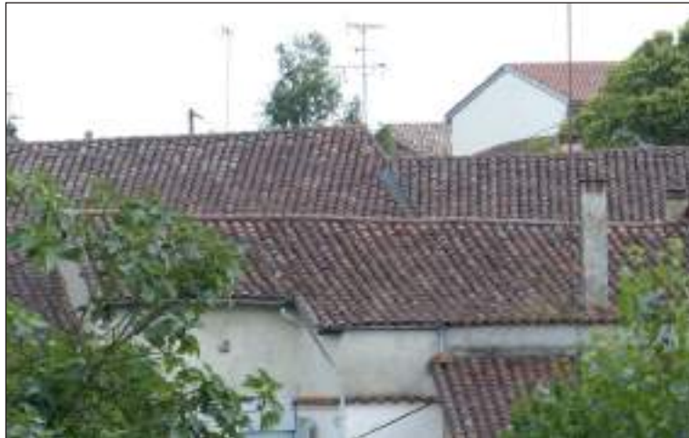
couvertures de tuiles canal
