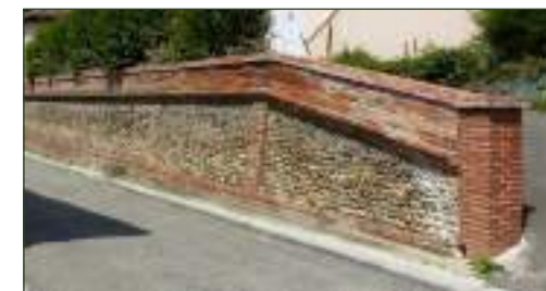
mur de soutènement : briques, assises de galets et chaperon plat
