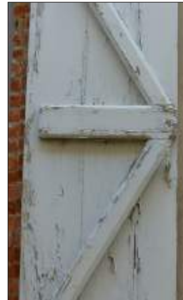
contrevents à écharpes chanfreinées - détail
