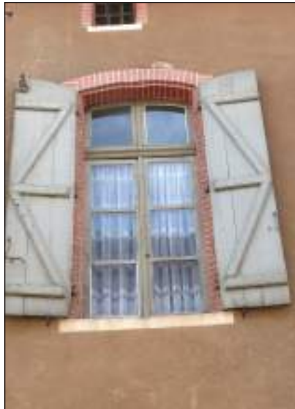
châssis à traverse dormante - contrevents à écharpes
