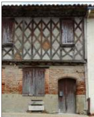
Façade en pan de bois d'intérêt majeur
