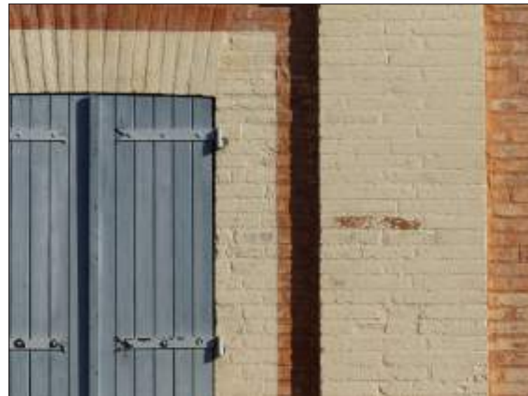
parement de briques cuites rehaussé par badigeon
