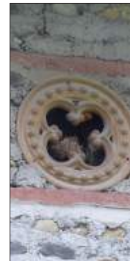
aération de comble néogothique
