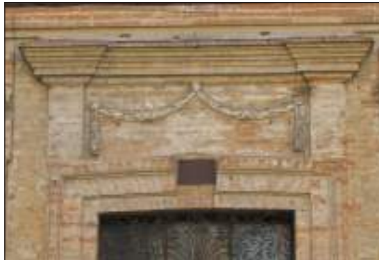
baies à entablement mouluré
