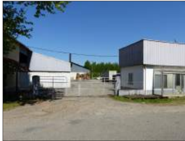
entrée de l'usine sur l'allée des Remparts
