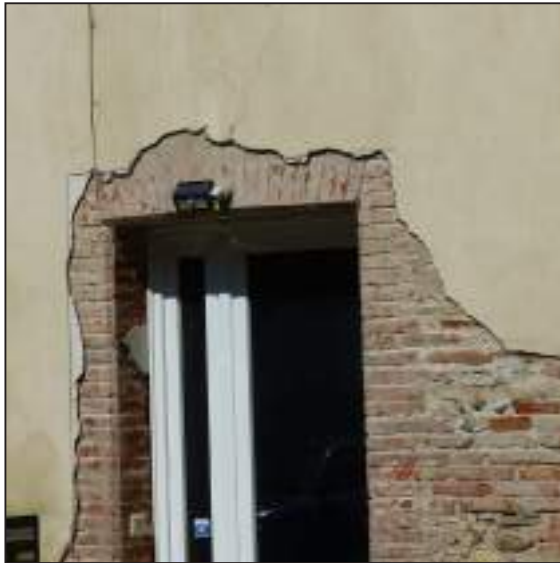
porte chanfreinée et appareil de briques
